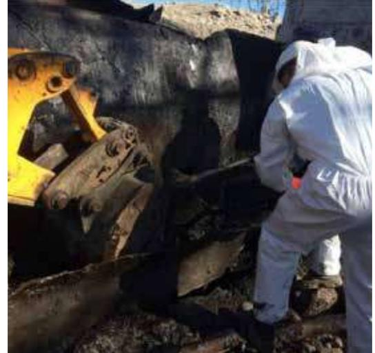
La complexité des galeries présentes sur site ne permettait pas d'avancer dans les phases de cassage avec des rendements importants. En effet, les phases de tri et d'orientation des matériaux pollués se réalisent à l'avancée du chantier afin d'éviter tout risque de mélange des matériaux sains et pollués.
